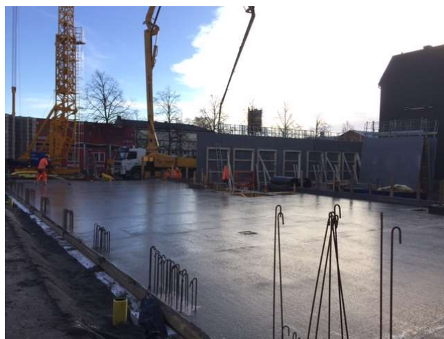
Hela bjälklaget gjutet!
