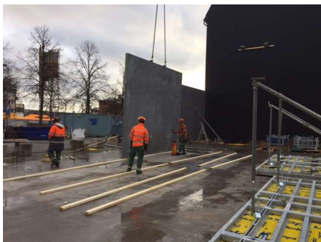
Här ställs väggformen upp.
