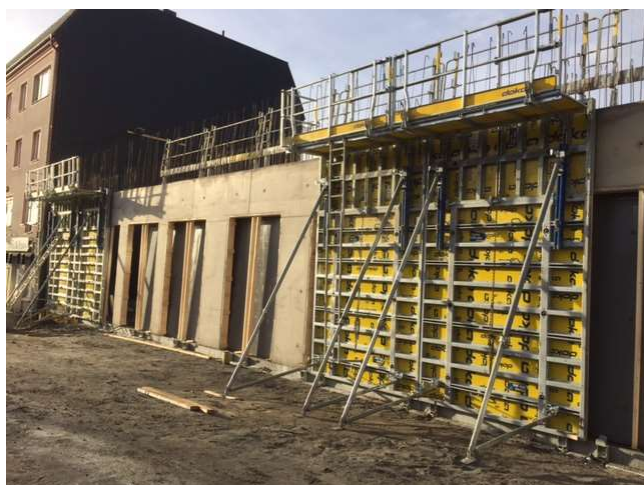
Delar av yttervägg mot Torggatan gjuten.
