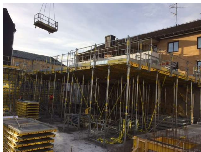
Valvform till gårdsbjälklaget uppställt!
