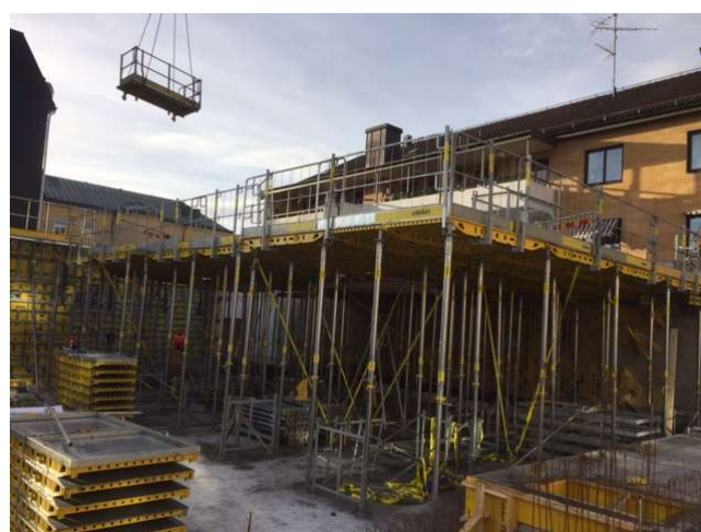
Valvform till gårdsbjälklaget uppställt!
