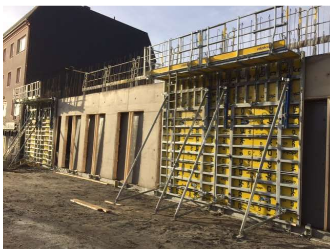
Delar av yttervägg mot Torggatan gjuten.
