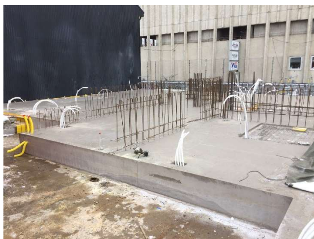
Hela bjälklaget gjutet.
