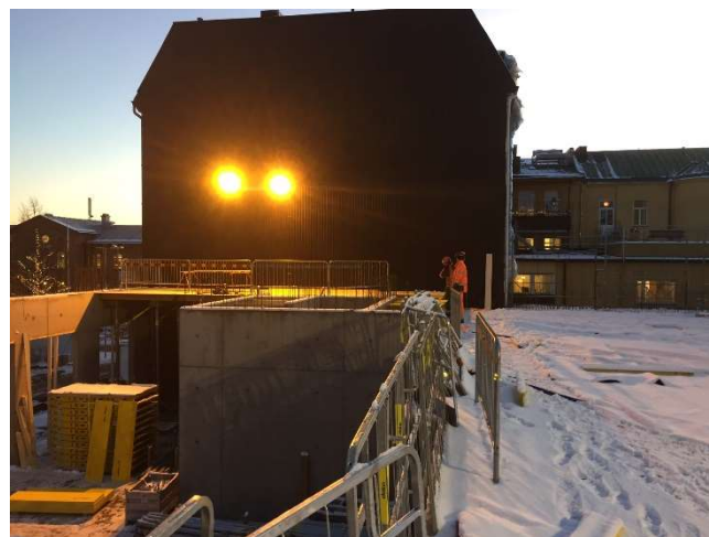
Valvform till gårdsbjälklaget uppställt!
